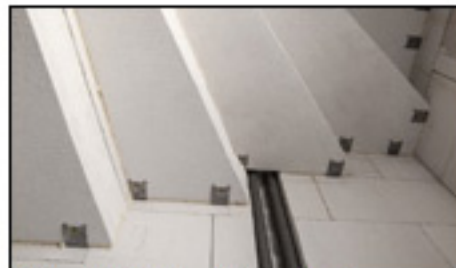
Obr. 3: Schodiskové stupne sa osádzajú po oboch stranách na murivo
