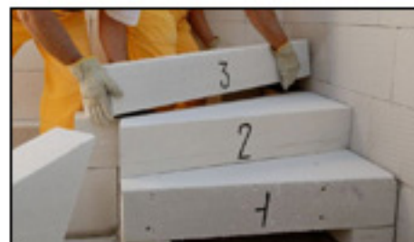
Obr. 1: Montáž schodiska s podmurovaním
