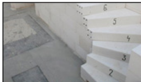
Obr. 2: Výstavba schodiska prebieha veľmi rýchlo
