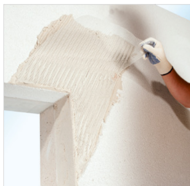
Aplikácia diagonálnej výstuže
