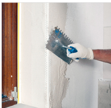
Inštalácia rohového profilu
