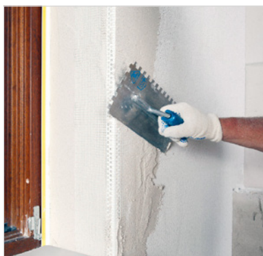
Inštalácia rohového profilu
