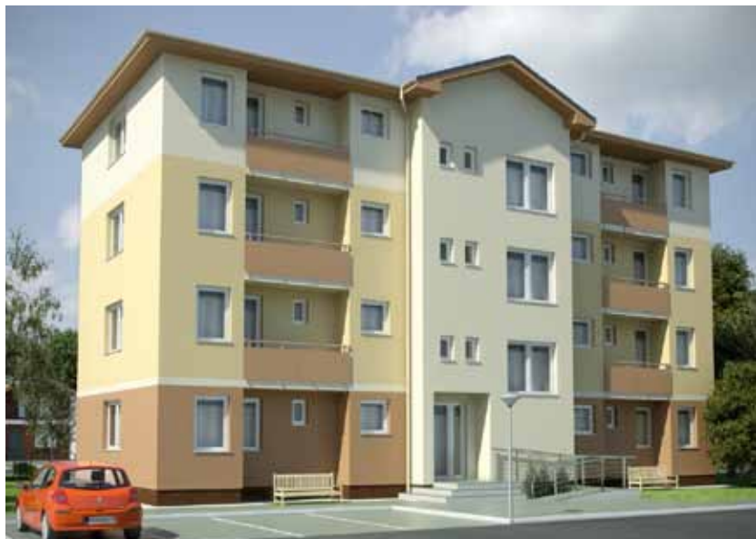
Obr. 1 Posudzovaný bytový dom ALLEX
